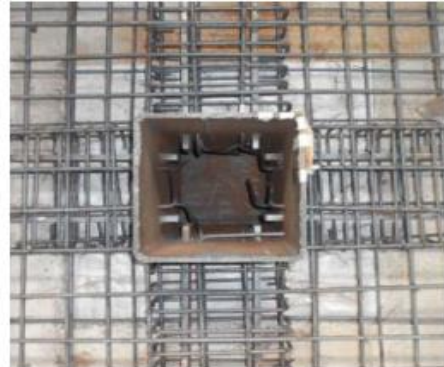
Hình 1.8. Liên kết cột CFST với sàn phẳng BTCT sử dụng tấm thép phẳng liên kết.
