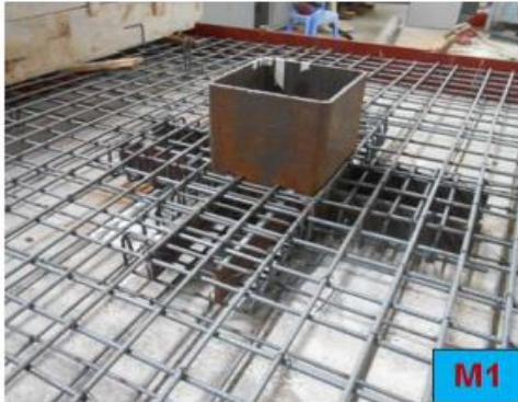
Hình 1.8. Liên kết cột CFST với sàn phẳng BTCT sử dụng tấm thép phẳng liên kết.
